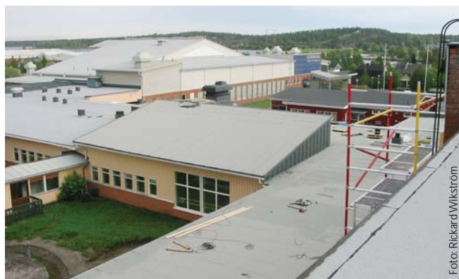
I den pågående om- och tillbyggnaden av Christinaskolan ingår bl a investeringar i ny ventilation och nya yttertak.
