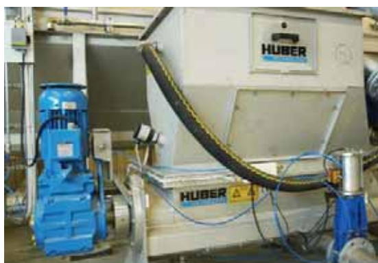
Tvättpress: Större fasta partiklar, t ex papper, plast, textilier, hår m m som avskiljts i reningsverkets fin-galler, tvättas och avvattnas och blir sedan till brännbart avfall.
