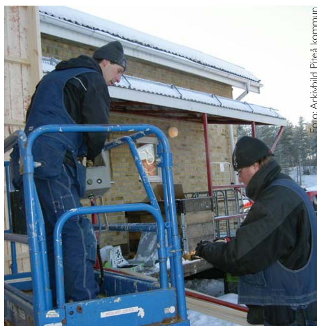
Här byggs en pelletsanläggning vid Sjulsmarks skola.
