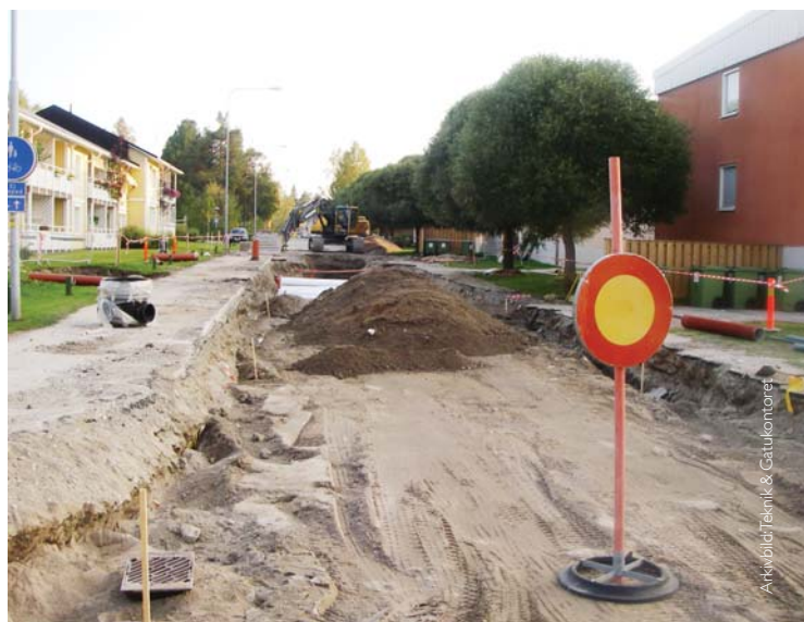
Teknik & Gatukontoret bygger om Furunäsvägen med nya VA-ledningar, ny gata inkl. gång- och cykelväg. Arbetet startade hösten 2006 och slutförs hösten 2007 till en beräknad kostnad av 6,2 mkr.
