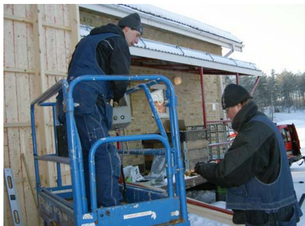
Peter Lundkvist och Robert Lundholm bygger pelletsanläggning för Sjulsmarks skola.
