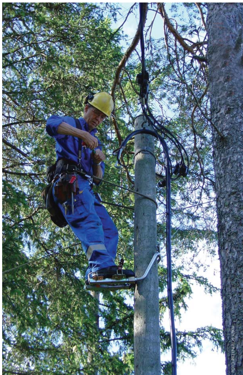
Gerhard Karlsson har klättrat upp i en stolpe för att utföra ett underhållsarbete på elförsörjningen.
