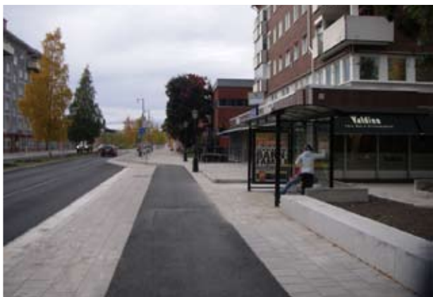
Ombyggnad av Sundsgatan till en trafiksäkrare och grönare stadsgata pågår. Arbetet sker i fyra etapper och hösten 2011 färdigställs den sista etappen.
