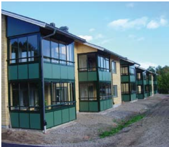
Fler hyreshus. PiteBo har byggt två hyreshus på Prästbovägen i Hortlax.
