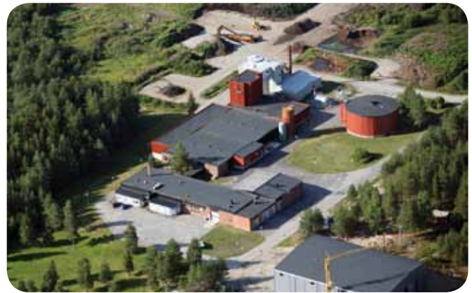
Sandholmens avloppsreningsverk tar emot och renar avloppsvatten från 35 000 pitebor. Foto: Tore Sundström
