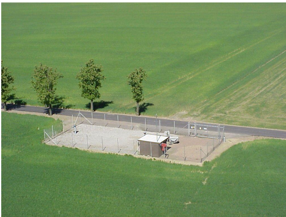
Figur 5. Exempel på linjeventilstation. Figuren visar det befintliga naturgassystemet. Justeringar kan förekomma i det slutliga skedet.
