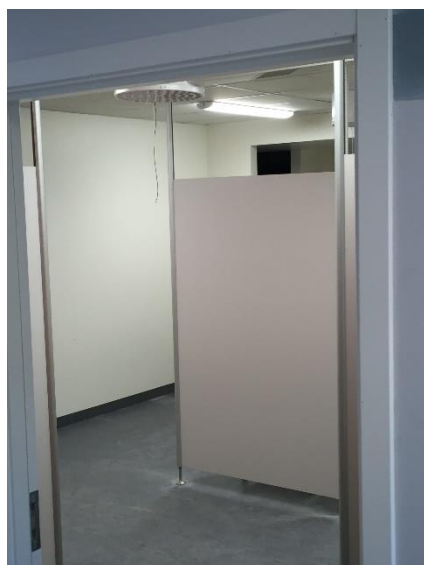
Bild 1 Insyn från korridor Strömnässkola
