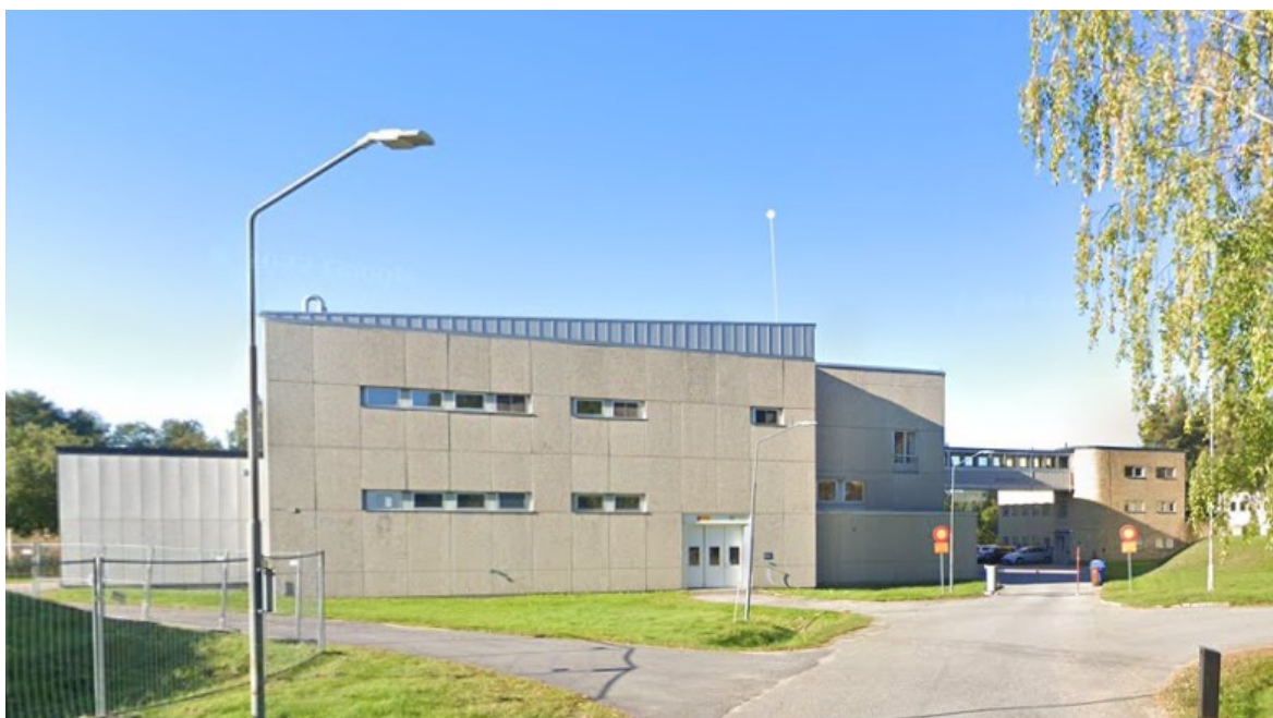
Figur 13. Foto på befintligt vattenverk: Källa Google maps.
