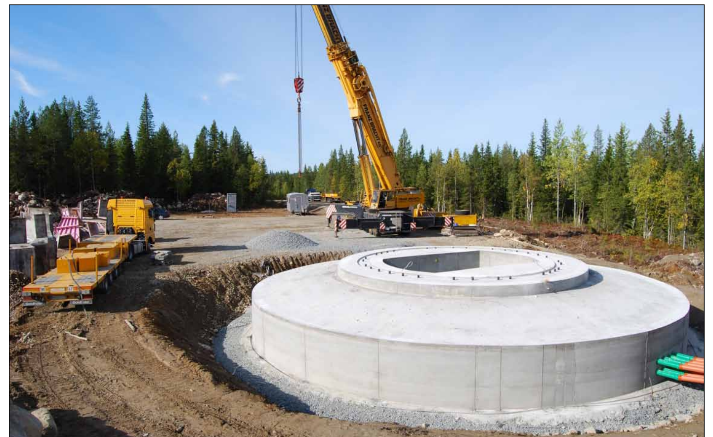
Fundament (foto: Jonas Lundmark).
