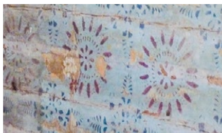
Under lager av tapeter kan finnas väl bevarade schablonmålningar. Dessa kan rekonstrueras genom att målningarna kalkeras av och nya schabloner skärs ut i plast.
