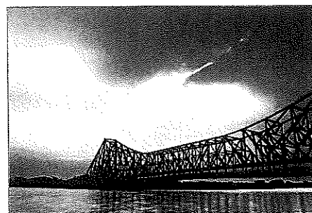
Howrah Bridge, en fackverksbro i Indien
