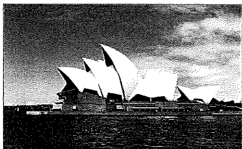
Operahuset i Sidney har betongvalv .
