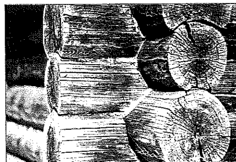
Knuttimrade hus byggs med liggande timmerstockar, som fogas samman med hjälp av urgröpningar i hörnen.
