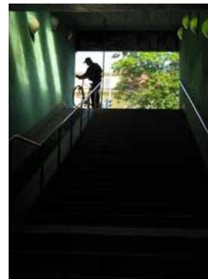
Figur 5.1.3 Gång- och cykelstråket är viktiga att utveckla. Bilden visar gångtunneln under järnvägen. Passagen har nyligen kompletterats med en hiss.
