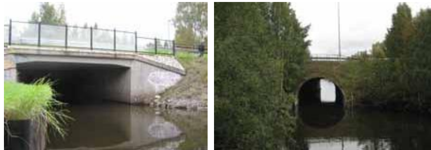
Figur 3.2.4 Kanalbroarna. Bron för järnvägen t.v. och vid Hertsöleden t.h Cirka 2 meters fri höjd vid normalt vattenstånd.
