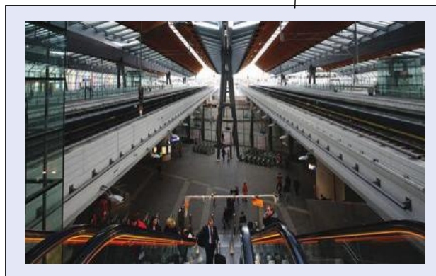
Plattformsentréer, nedgångar till bussterminal under gemensamt tak, Biljmerstation Ajax, Holland.
