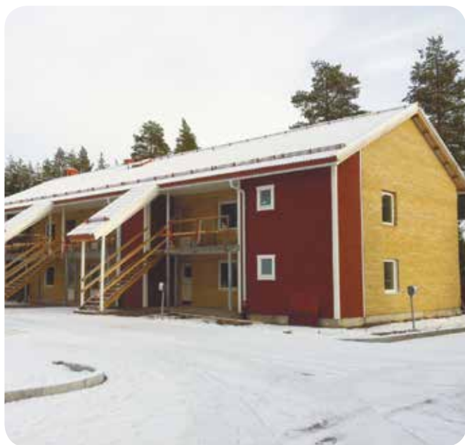
Elevbygget på Tryffelvägen under uppförande.
