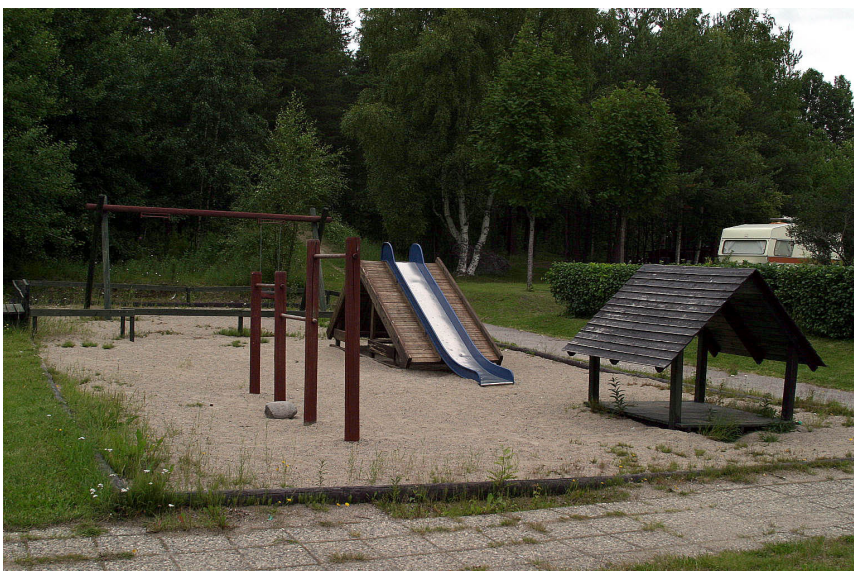
Exempel på en gammal lekmiljö som inte inbjuder till lek. Renoveringsbehovet är stort.
