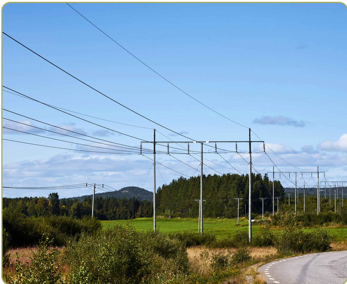
Elnätet i Munksunds stadsdelscentrum har i dagsläget ca 1350 elabonnenter. Foto: Maria Fäldt.
