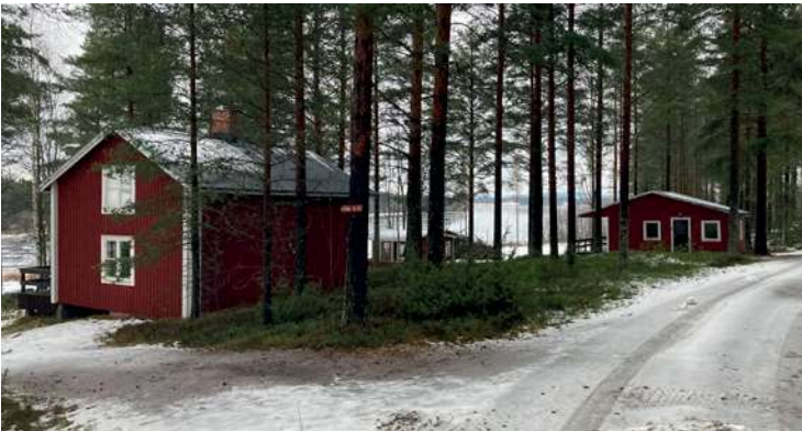
Timrat härbre, delvis klätt i lockpanel, rödmålad. Står på stolpar och grundsten (natursten). Foto: Tomas Örn, 2020.
